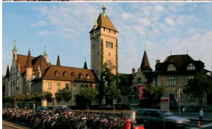
Sanierung und Umbau Landesmuseum in Zürich APT Ingenieure GmbH, Zürich
